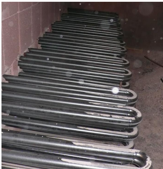
Obr.1 Pohled do spalovací komory odstaveného kotle
