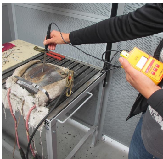
Obr. 5: TARC ETE, měření teploty interpass během svařování
