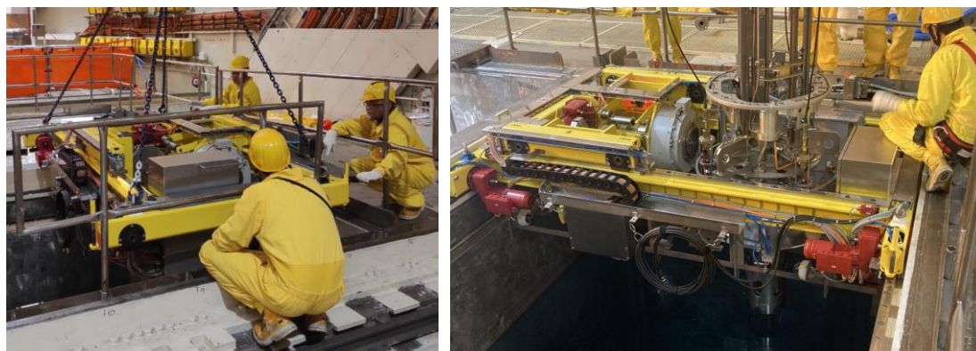
Obr. 3. Vlevo montáž mostu na koleje, vpravo montáž sloupu do mostu SI-PS
