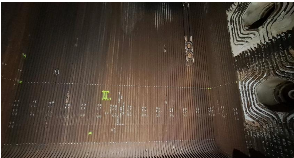
Obr. 6: Označení měřených trubek na stěně č. 2
