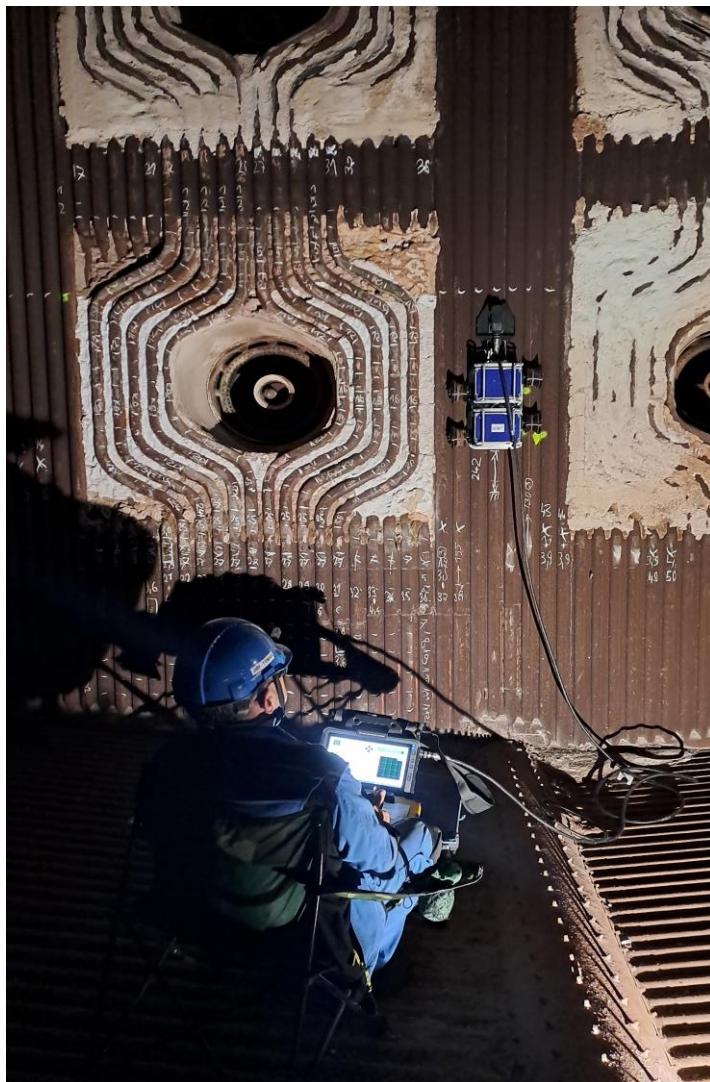
Obr. 10: Možné použití automatizovaného nosiče sond pro skenování trubek kotle po celé výšce (délce). Lze použít i pro šikmý sklon trubek membránové stěny.
