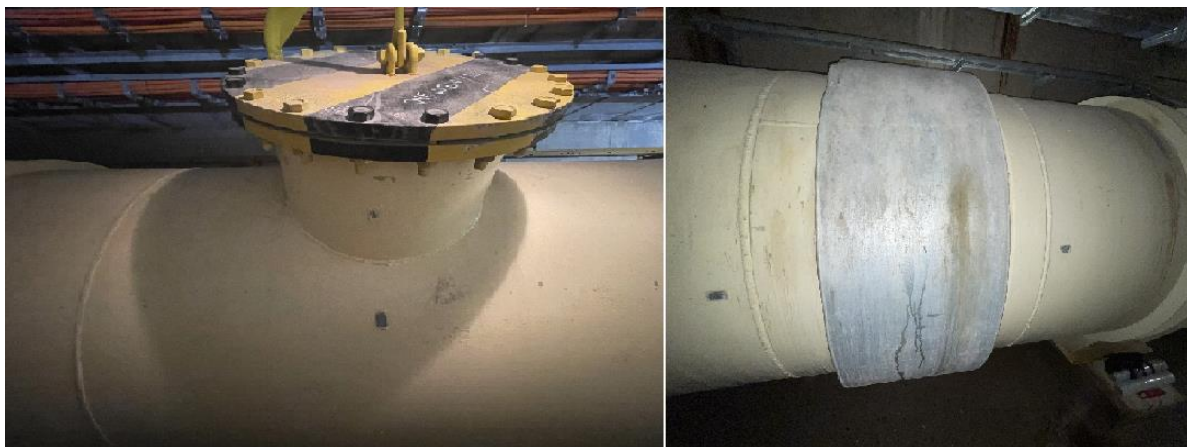
Obr. 1: Lokalita vlezů do potrubí a kompenzátoru potrubí
